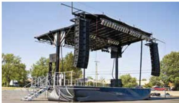
5 Toit et équipements entièrement montés. Installation des escaliers et des rampes, ajout des accessoires.
